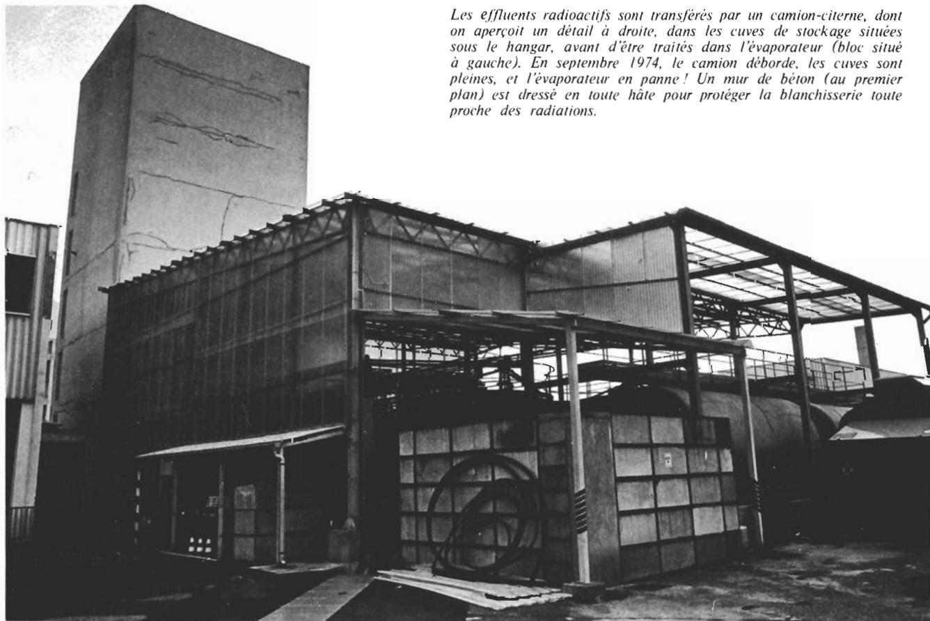
*Les effluents radioactifs sont transférés par un camion-citerne, dont on aperçoit un détail à droite, dans les cuves de stockage situées sous le hangar, avant d'être traités dans l'évaporateur (bloc situé à gauche). En septembre 1974, le camion déborde, les cuves sont pleines, et l'évaporateur en panne ! Un mur de béton (au premier plan) est dressé en toute hâte pour protéger la blanchisserie toute proche des radiations.*
