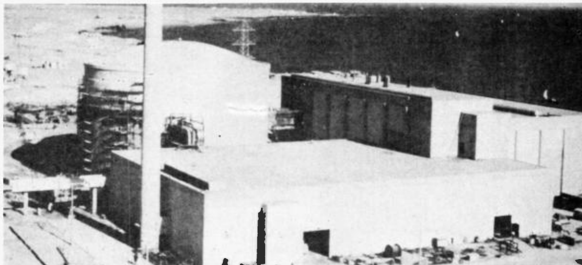
La centrale nucléaire KANUPP à Karachi est une centrale CANDU, dont la conception a été fondée sur celle de la première centrale nucléaire du Canada. Elle fonctionne depuis le début des années 1970.
