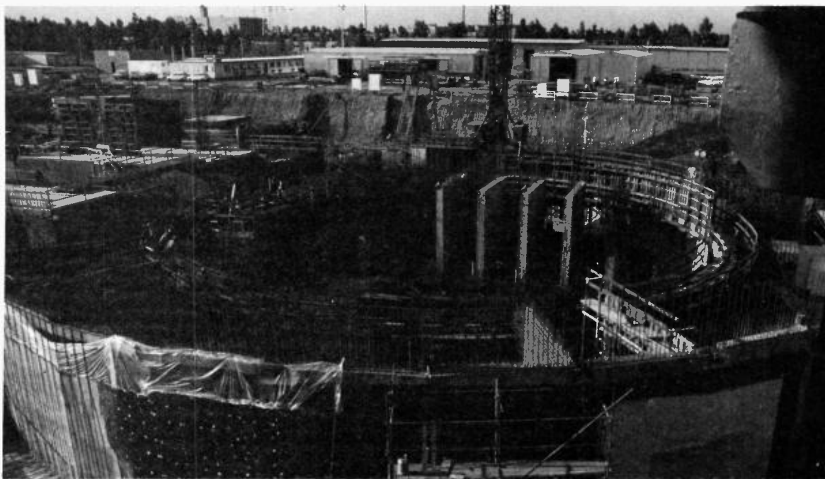
Osirak, en construction. Ce réacteur fut bombardé par l'aviation israélienne le 7 juin 1981. (Cliché Marc Riboud).
