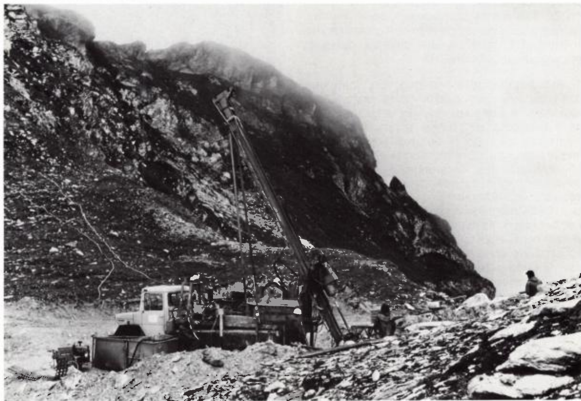
sondage carotté en montagne
