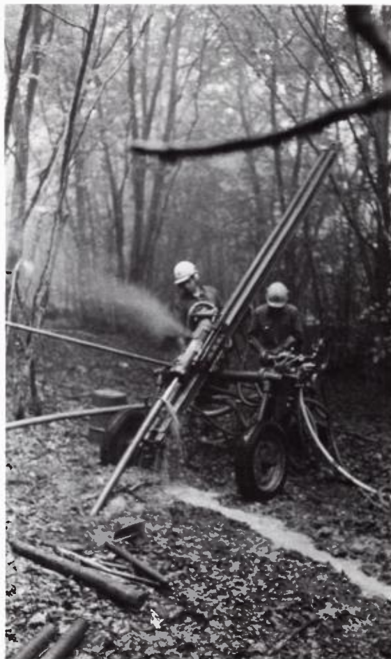
sondage de prospection incliné
