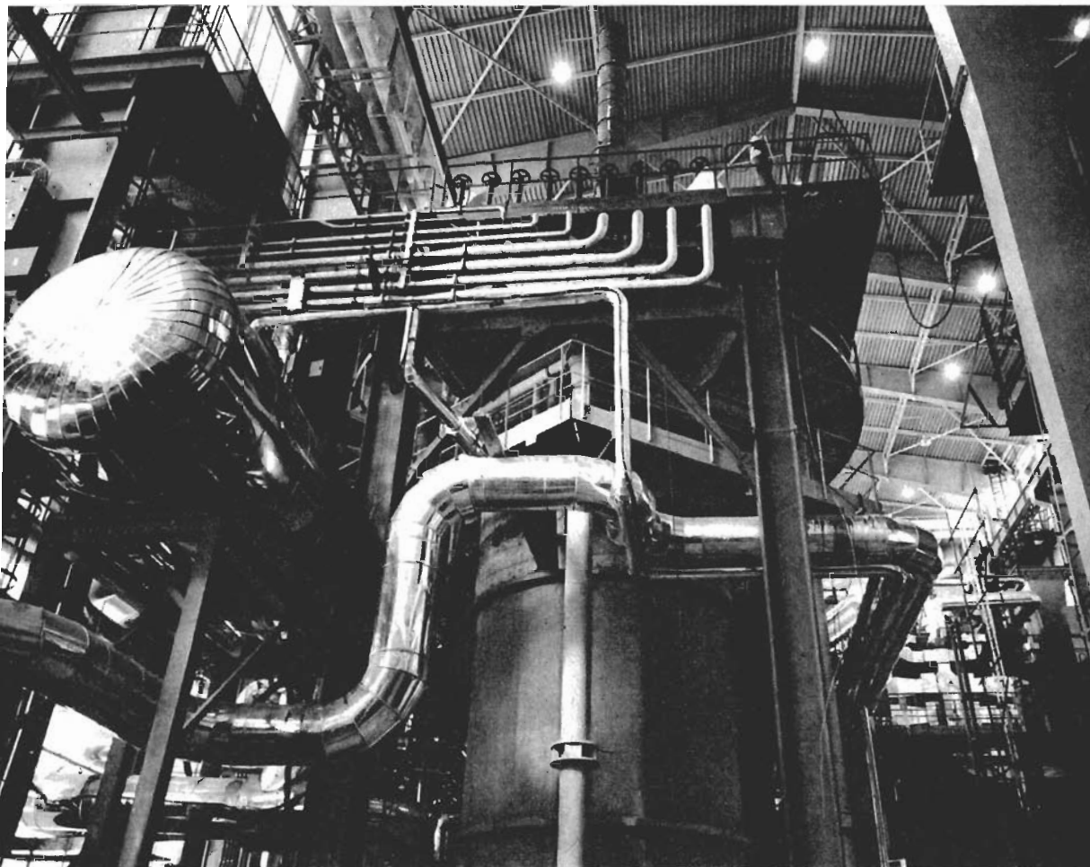
Hall des essais de Rapsodie. Maquette du bloc pile : cuve et réservoir de charge.
