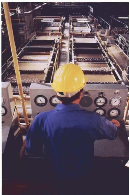
Les filtres à bande. (Photo COGEMA).
