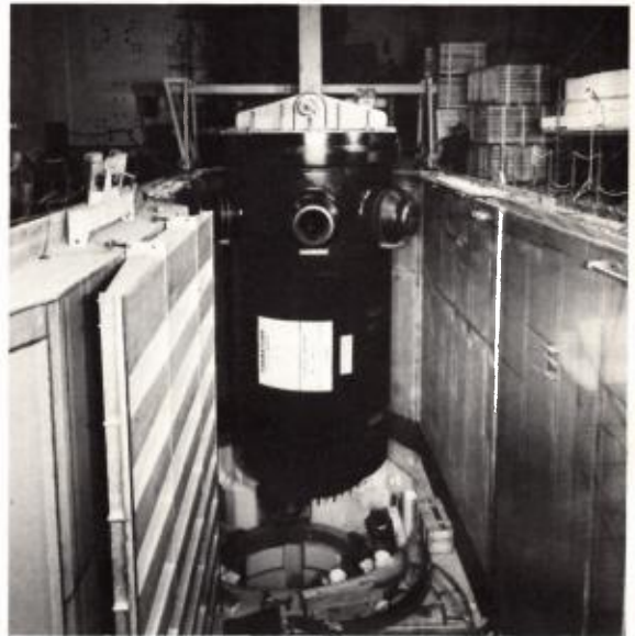
mise en place de la cuve du réacteur de la centrale du Bugey II
