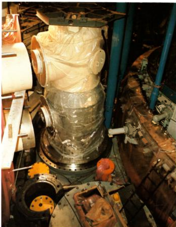
Septembre 1982 - Échangeur intermédiaire en cours de raccordement.
