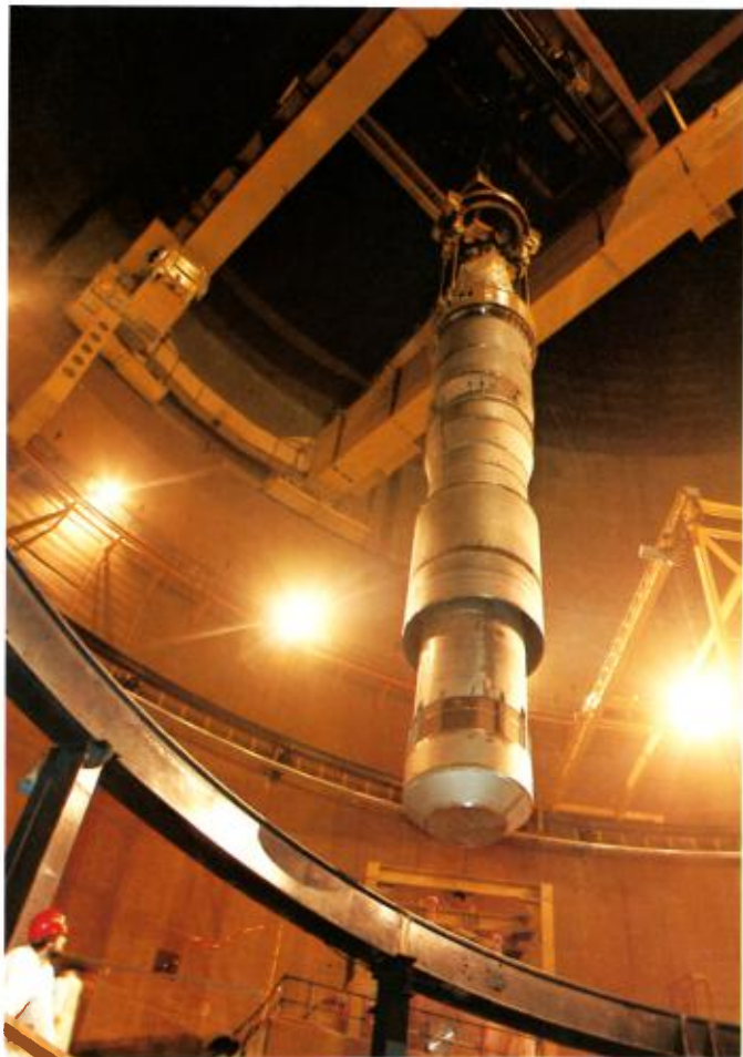
Septembre 1982 - Échangeur intermédiaire en cours de manutention dans le bâtiment réacteur.
