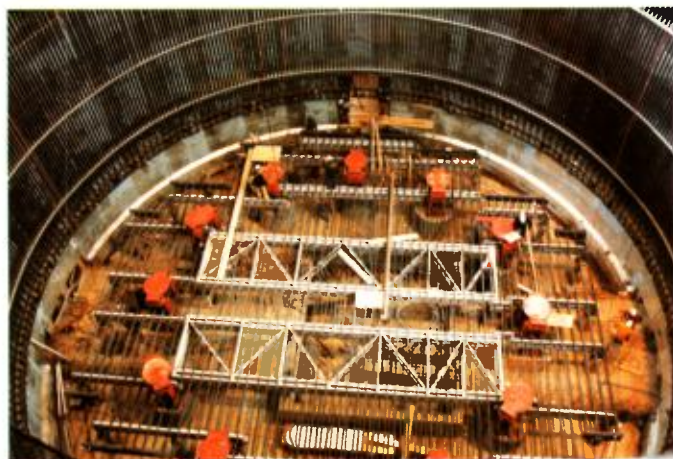
23 Avril 1980 - Vue intérieure du puits de cuve et de son circuit de refroidissement.
