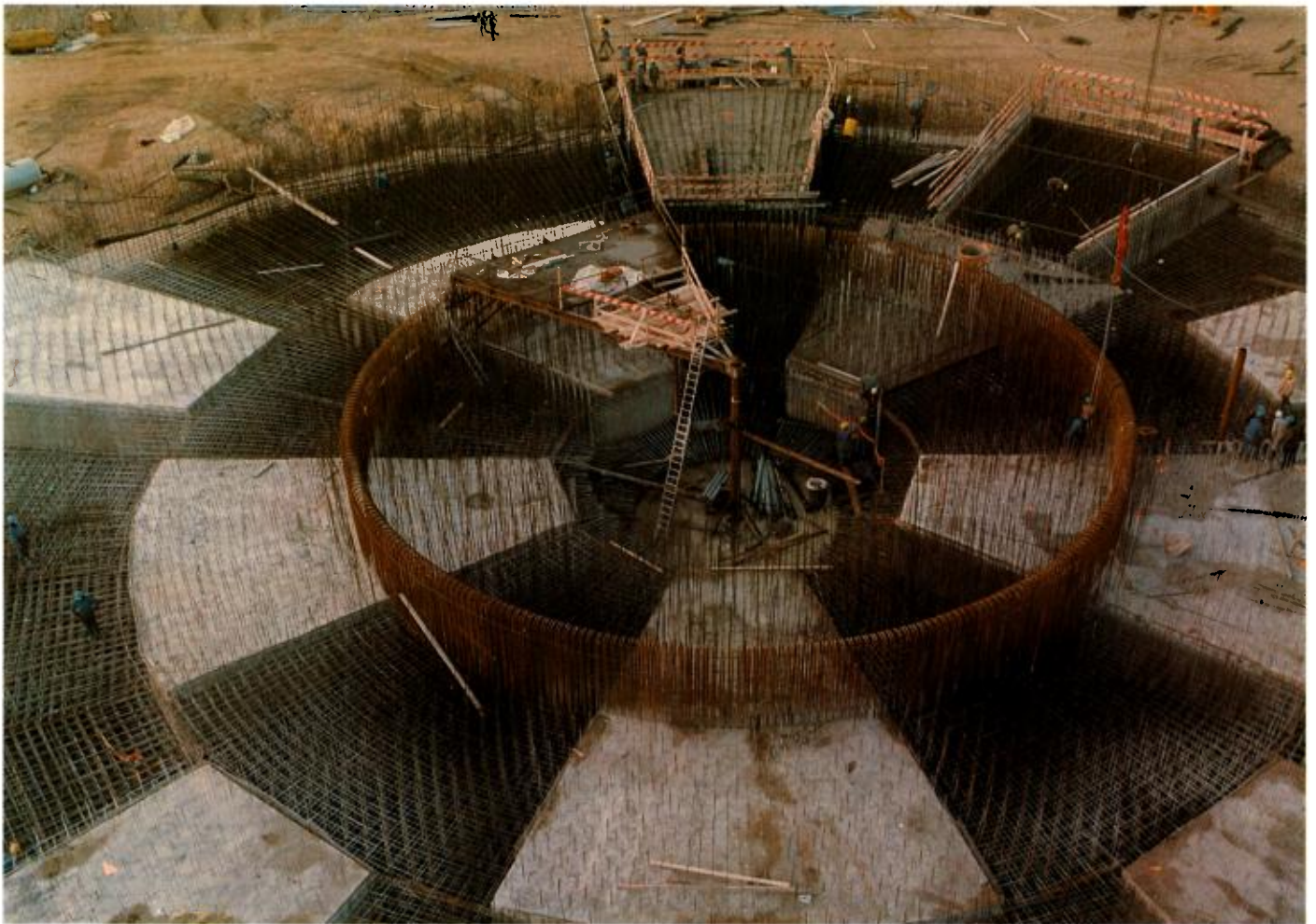
20 Janvier 1977 - Le radier du bâtiment réacteur en cours d'exécution.
