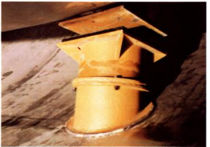
25 août 1980 – Vue pendant le montage de l'espace entre cuve principale et cuve de sécurité.
