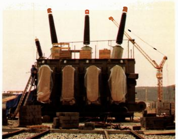
CREYS-MALVILLE - mars 1980 : un des transformateurs principaux devant sa logette
