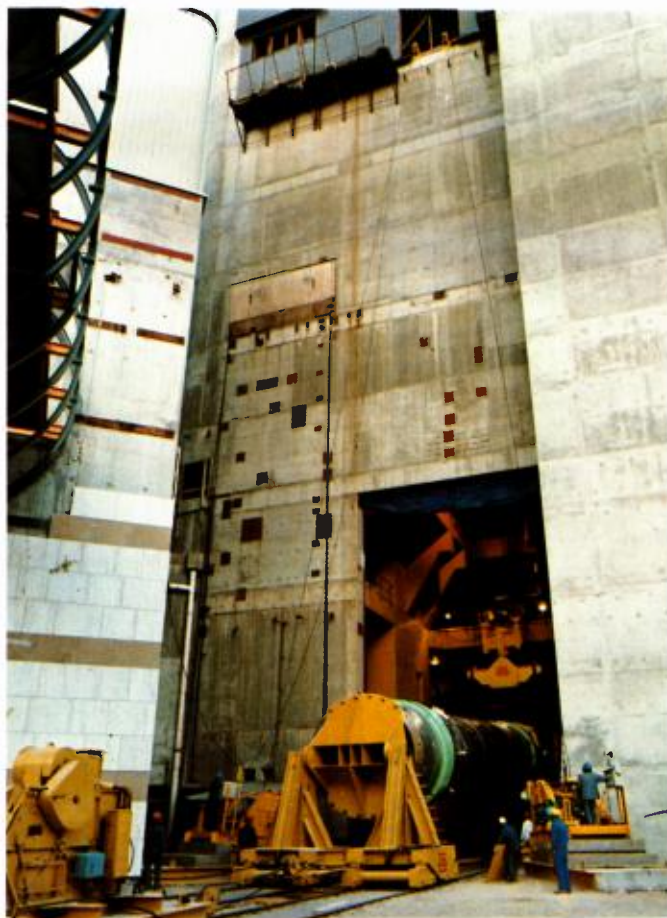
Introduction d'un générateur de vapeur dans son bâtiment.
