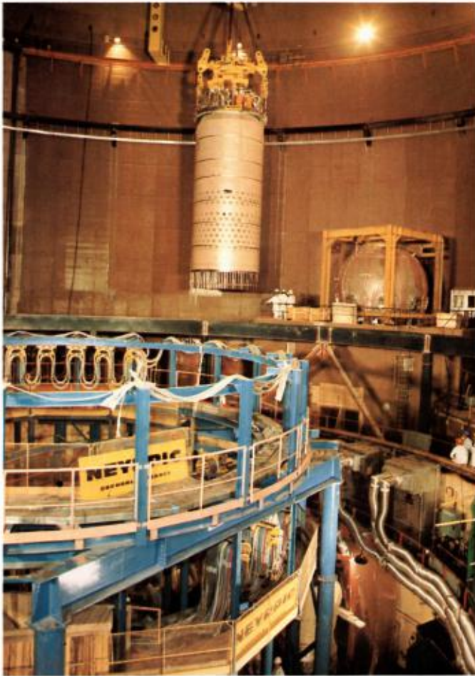
5 Août 1982 - Mise en place du bouchon couvercle du cœur.
