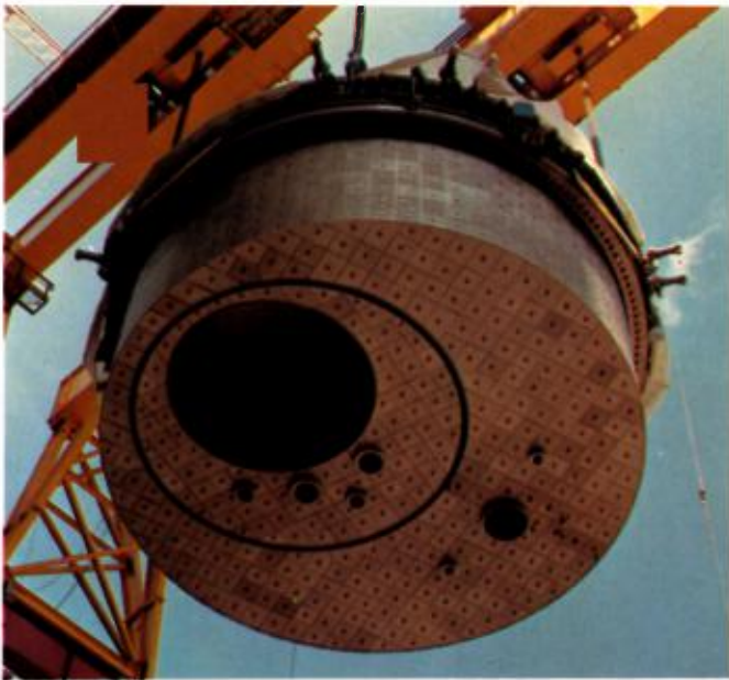
Avril 1980 Neyrpic – Vue du système de mise en rotation du petit bouchon tournant (PBT).
