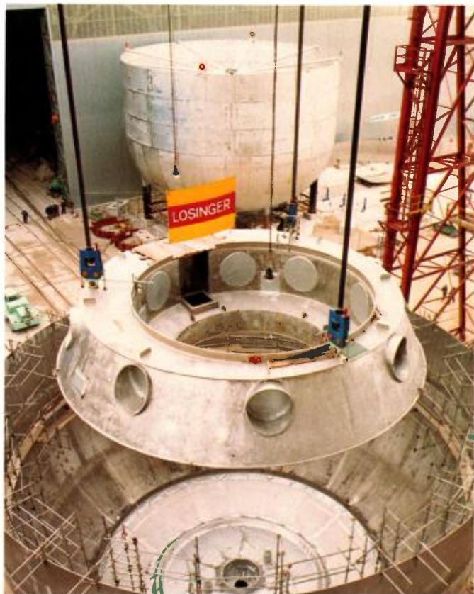
17 avril 1980 – Mise en place du platelage dans la cuve principale.
