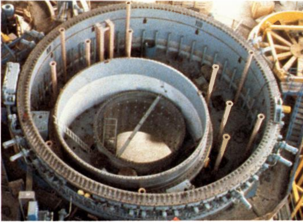
20 Octobre 1980 – Atelier de Creys-Malville. L'ensemble des bouchons tournants.
