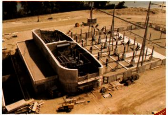
CREYS-MALVILLE - septembre 1980 : plateforme des transformateurs auxiliaires
