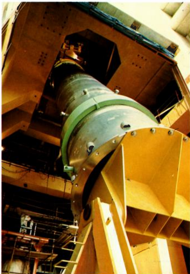
Générateur de vapeur en cours de levage pour mise en place dans son bâtiment. Le poids d'un générateur de vapeur est de 191 tonnes.
