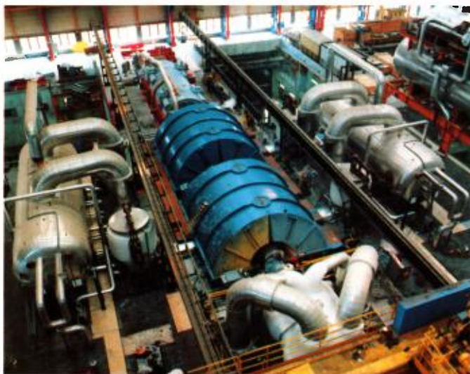
Octobre 1983 – Vue générale d'une demi-salle des machines. Le groupe monté est encadré par ses deux sécheurs surchauffeurs.
