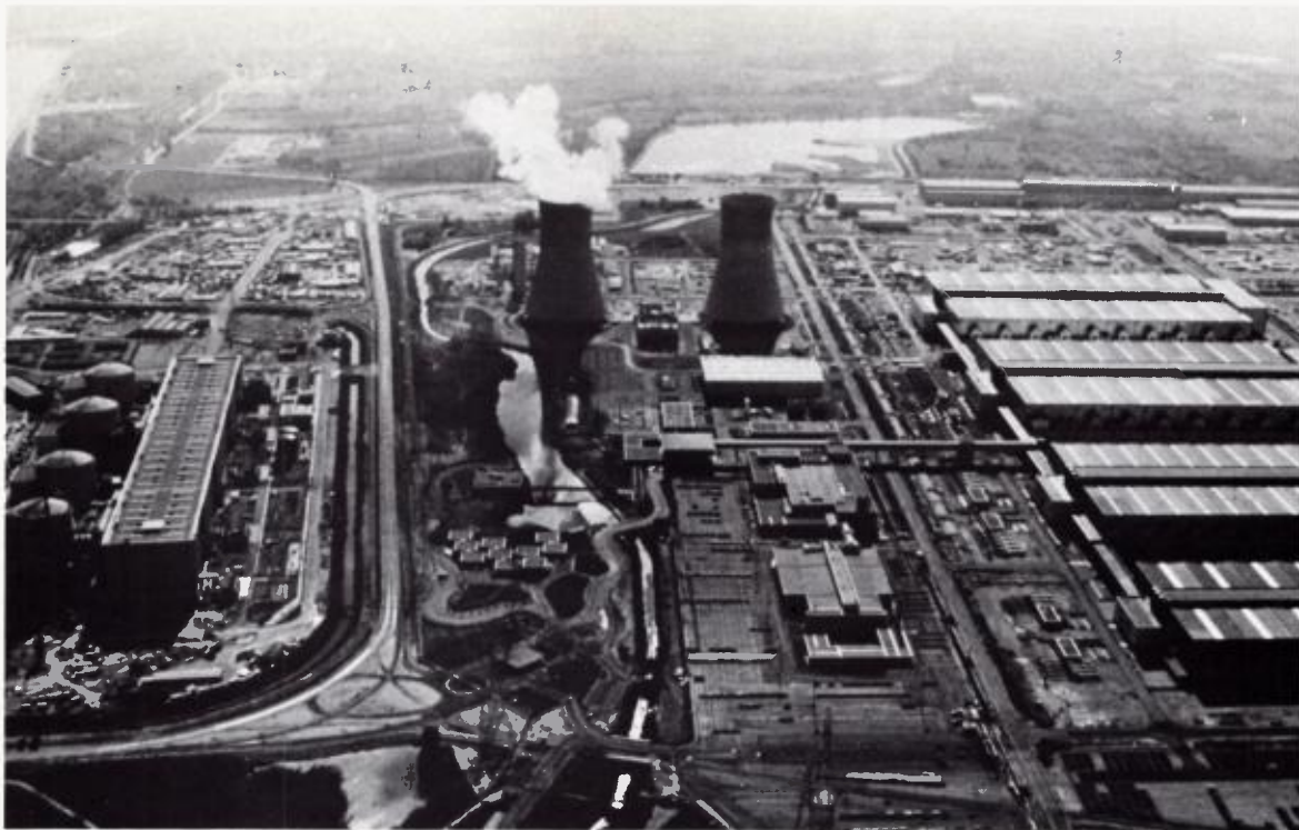
le complexe Eurodif du Tricastin où s'effectue l'enrichissement isotopique de l'uranium pour les besoins d'une centaine de réacteurs
