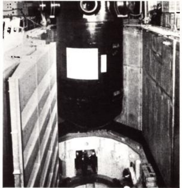
mise en place de la cuve du réacteur de la centrale du Bugey II
