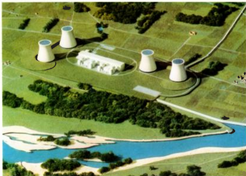
Maquette de la centrale de Dampierre-en-Burly.
