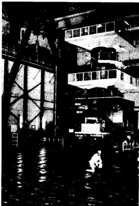
b. La dalle supérieure du réacteur de Saint-Laurent-des-Eaux. Au fond, la machine de chargement des combustibles.
