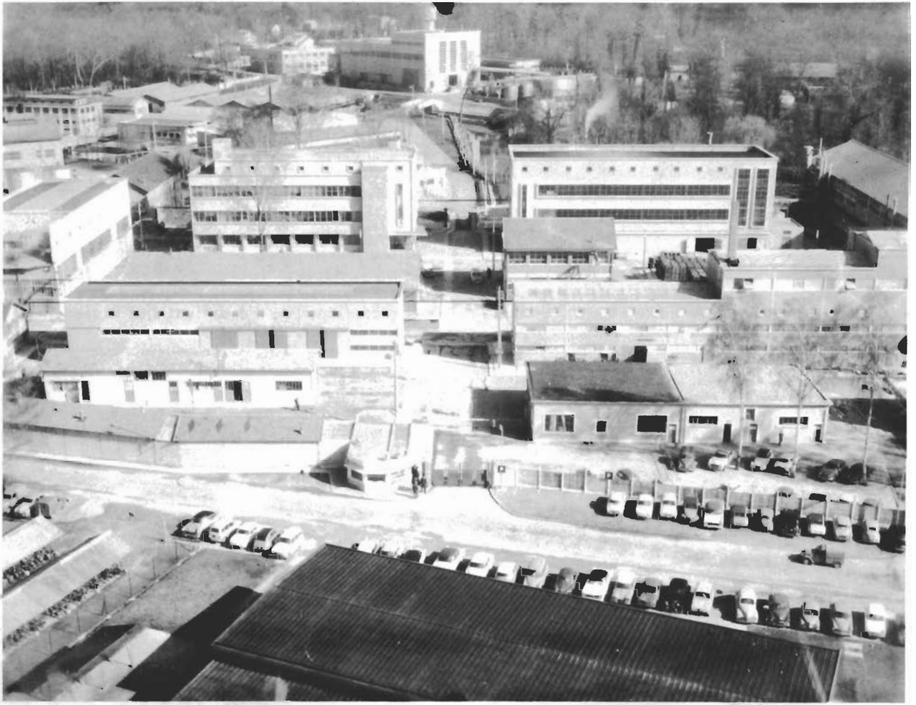
Fig. 11. — Vue générale prise d'hélicoptère.
