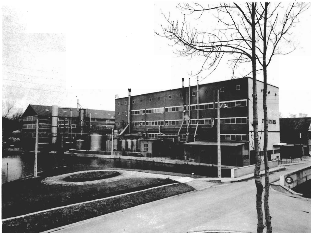
Fig. 4. — Fabrication Uranium : Bâtiment Purification.
