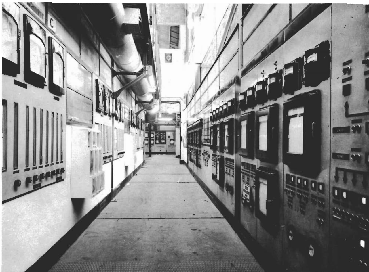
Fig. 7. — Bâtiment Fluoruration. Vue intérieure.
