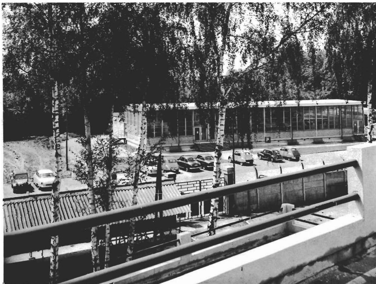
Fig. 10. — Vue sur la Cantine.
