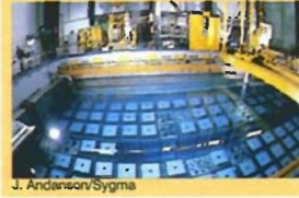
Stockage en piscine
