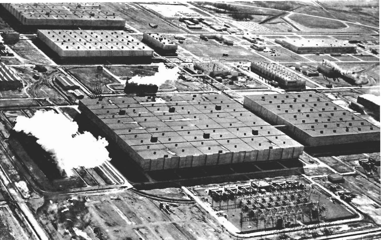
C'est par milliers de tonnes que l'uranium naturel transformé en hexafluorure est traité depuis des années par ces géantes installations de séparation isotopique d'Oak Ridge. Ces installations doublent en quelque sorte les non moins géantes installations plutoniques d'outre-Atlantique. Leur richesse a permis aux U.S.A. de jouer les deux cartes.
