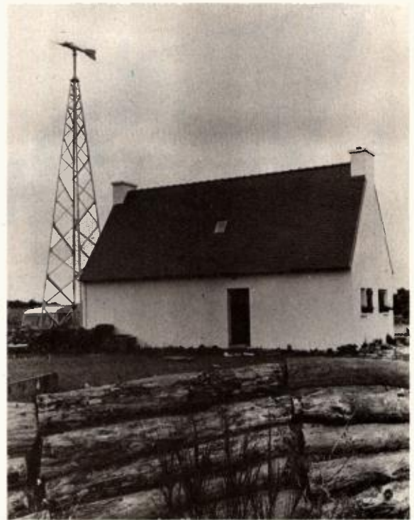
éolienne à Kermathéano près de Plomeur
