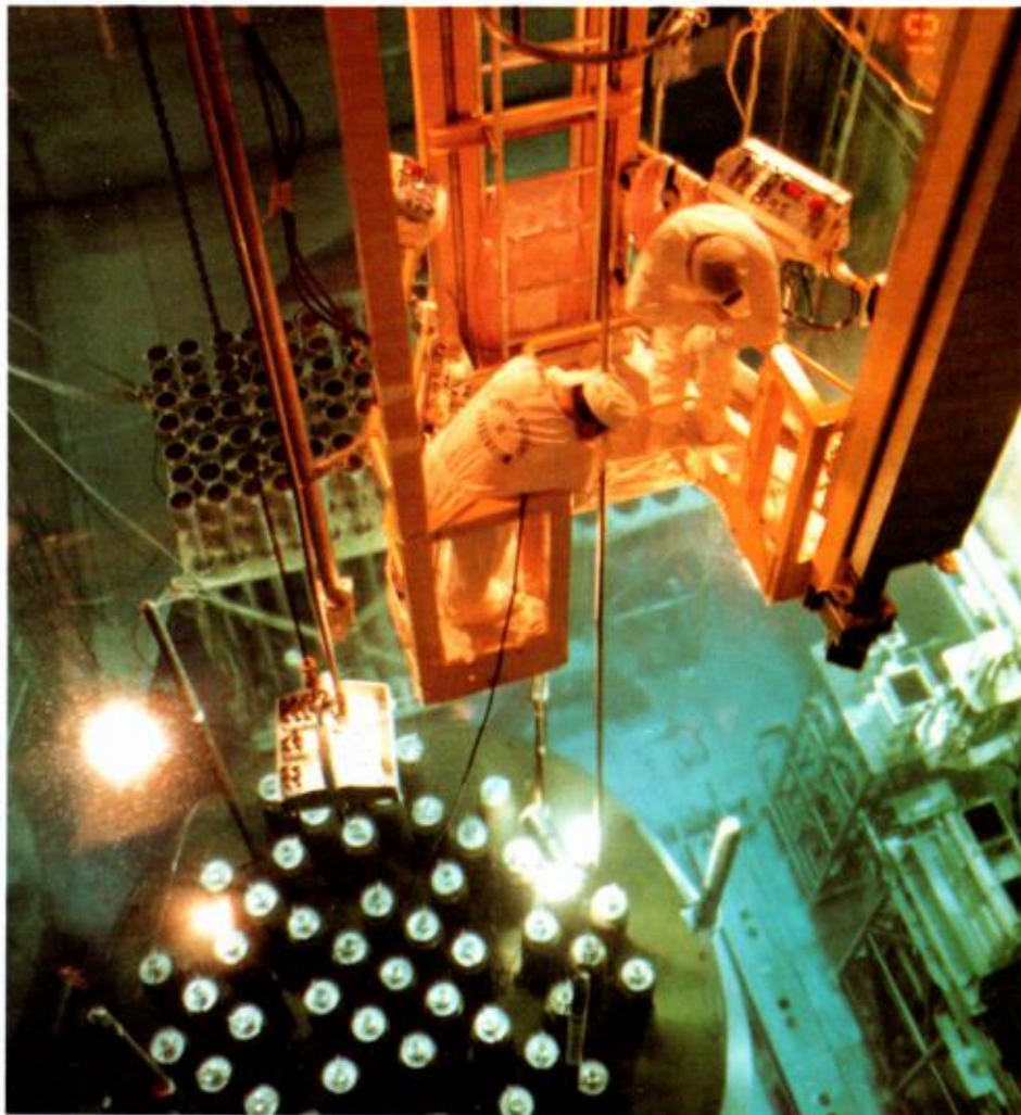
Visite décennale Chantier des tubes-guides
