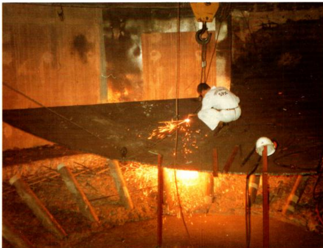
Le chantier barillet
