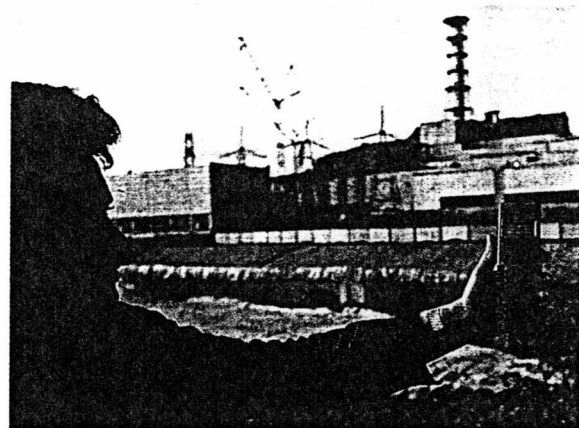
▲ La centrale : en noir, le sarcopha- ge ; 300 000 m 3 de béton et, omniprésent : le compteur Geiger.
